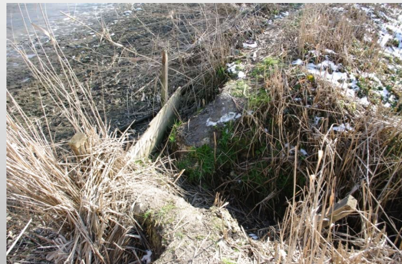
Provizorní oprava hráze
