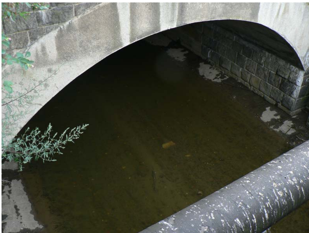
Obrázek č. 9 – vtok Botiče do zaklenutého úseku (Ostrčilovo náměstí).
