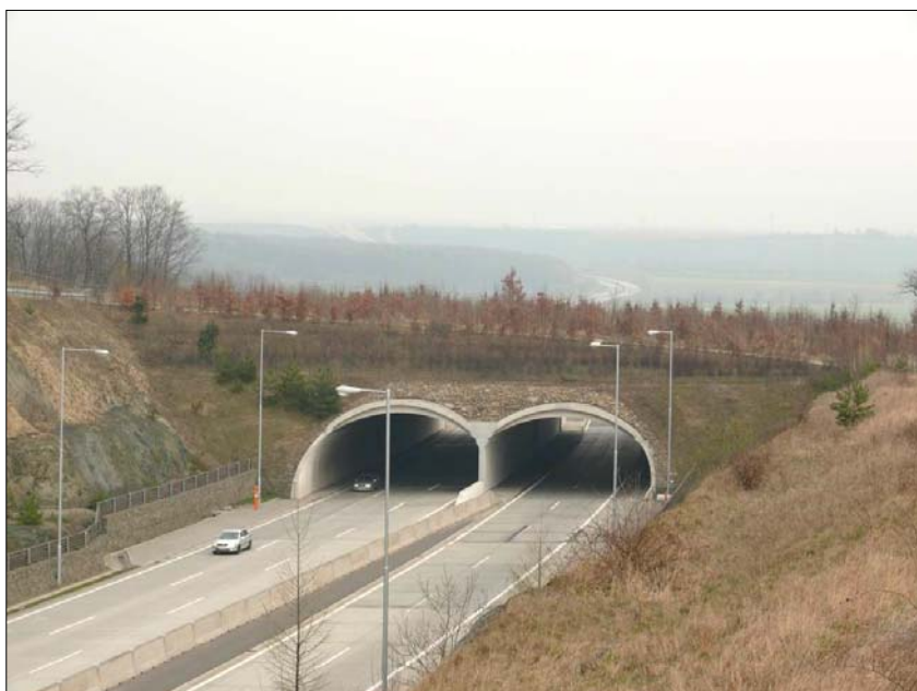
Ekodukt na rychlostní silnici R35 u Dolního Újezda, první stavba tohoto typu na našem území, postaven v roce 1999. Foto – stav k 5. 4. 2009
